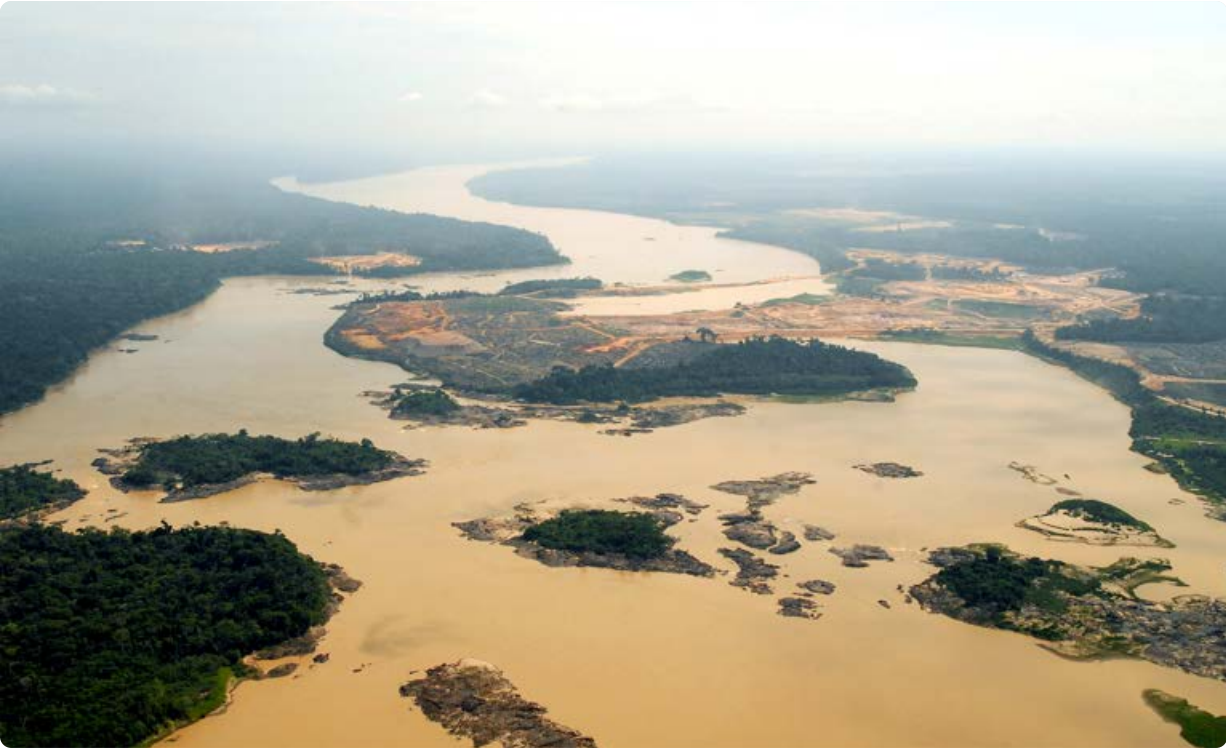
Vista aérea do rio Madeira durante a construção da usina.
