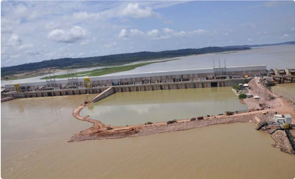
Remoção das ensecadeiras e início da passagem da água.
