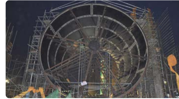
Com o progresso das obras, avançar com a montagem eletromecânica e o comissionamento das turbinas ganhava ainda mais importância.
