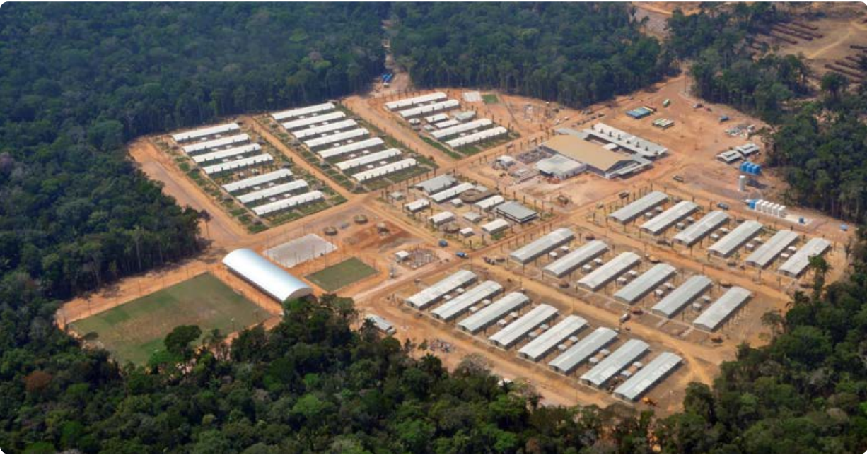
Refletindo o padrão elevado que o consórcio desejava imprimir ao projeto, os alojamentos (no alto, da margem direita; abaixo, da margem esquerda) tinham ar-condicionado e acomodavam, no máximo, oito trabalhadores por unidade. Além disso, as mulheres ficavam em alojamentos exclusivos, reforçando um ambiente mais seguro e inclusivo.
