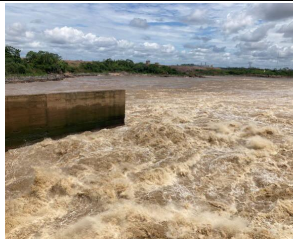
Foto 35: Vista a jusante do vertedouro, com 3 comportas parcialmente abertas
