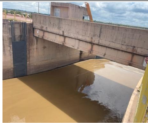
Foto 38: Vista a montante do vertedouro de troncos
