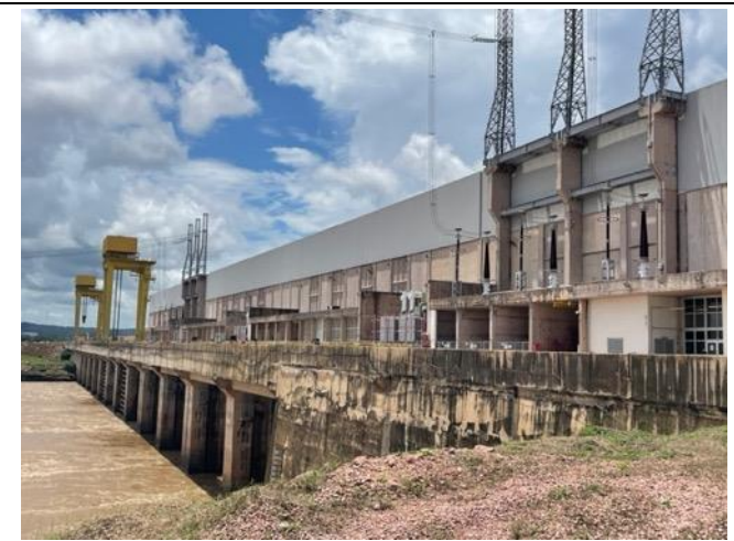
Foto 33: Casa de força da margem esquerda a partir da jusante
