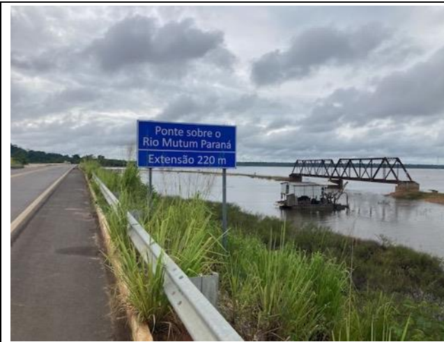
Foto 19: Rodovia e pontes ferroviárias históricas sobre o rio Mutum e barçaça de mineração de ouro, perto da antiga Mutum Paraná
