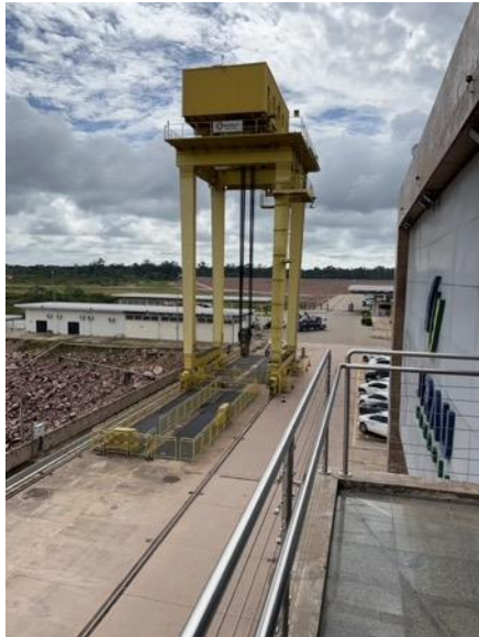
Foto 43: Guindaste stop-log a jusante
