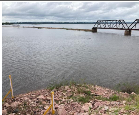
Foto 20: Medidores de nível de água com linha ferroviária histórica ao fundo
