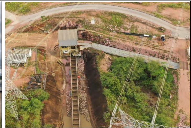
Foto 105: Vista aérea de uma das duas instalações de passagem de peixes, com canal de aproximação, prédio de triagem com elevadores e bacias de retenção, e tubulações que fornecem água bombeada (foto fornecida pela ESBR)
