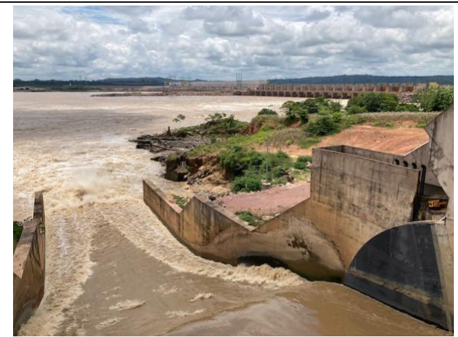
Foto 39: Vertedouro de troncos com vertedouro principal e casa de força da margem direita ao fundo
