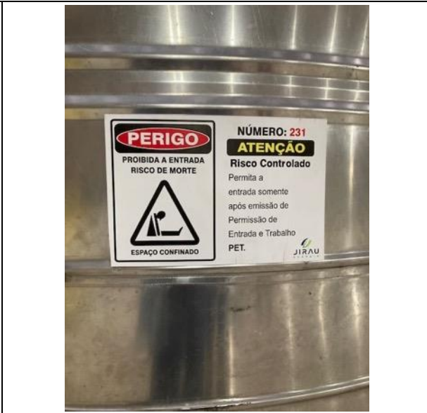
Foto 56: Etiqueta de aviso de espaço confinado
