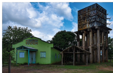
Caixa d'água - Remanescentes E.F.M.M. - Abunã.
